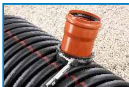
F. Ahora presione la tubería hacia abajo, hasta el tope. Apretando la abrazadera a 6 Nm
