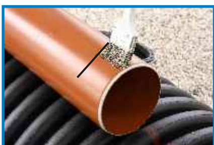
E. Marcar el lateral de la tubería Lubricar tubería y LTC
