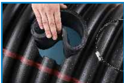
C. Presionar e introducir el casquillo (LTC) en la conexión lateral
