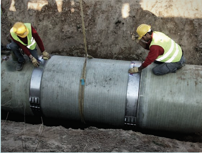
Fig. 1 / Montaje de tuberías de PRFV de gran diámetro.
