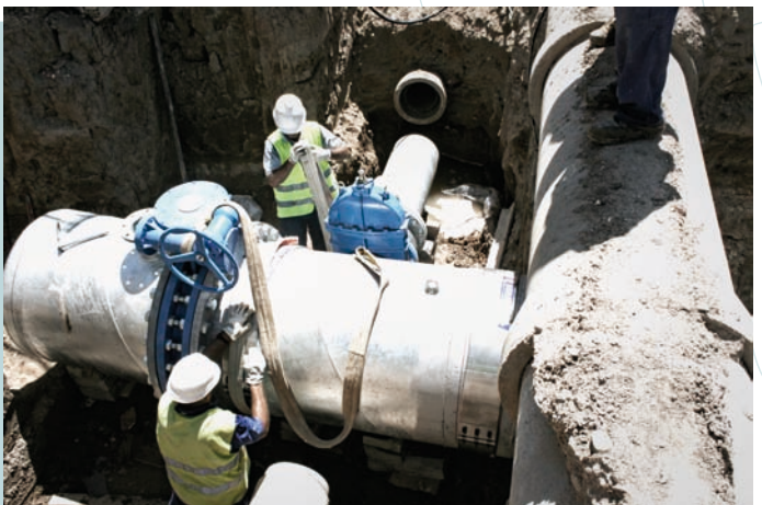
Fig. 6 / Montaje de tuberías y accesorios.
