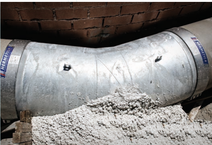
Fig. 5 / Montaje de tuberías y accesorios de diferentes materiales.
