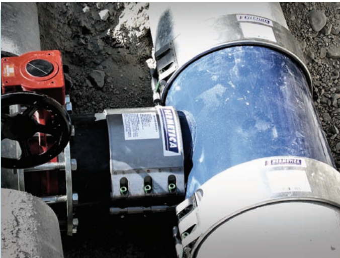
Fig. 3 / Montaje de tuberías y accesorios de diferentes materiales.
