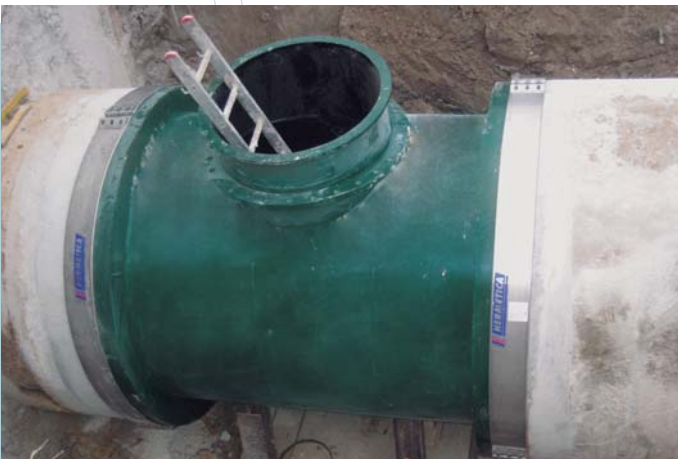
Fig. 5 / Instalación de registro de inspección para tuberías de gran diámetro.
