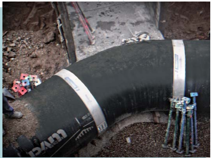
Fig. 4 / Montaje de codo en tubería de fundición.
