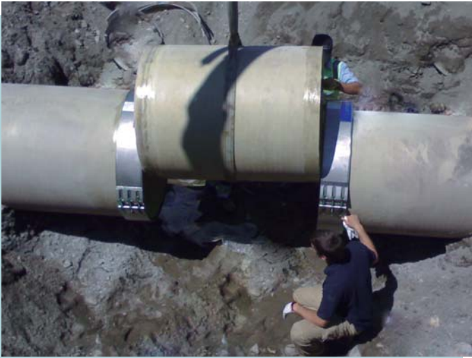
Fig. 1 / Reparación con carrete en tubería de gran diámetro de PRFV.
