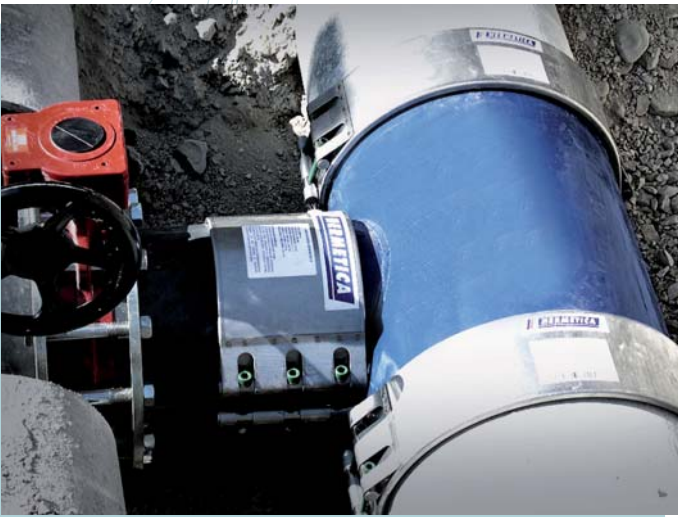
Fig. 3 / Montaje de tuberías y accesorios en diferentes materiales.
