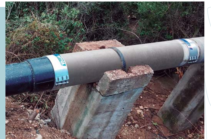
Fig. 6 / Reparación en tubería aérea con diferentes materiales y diámetros.
