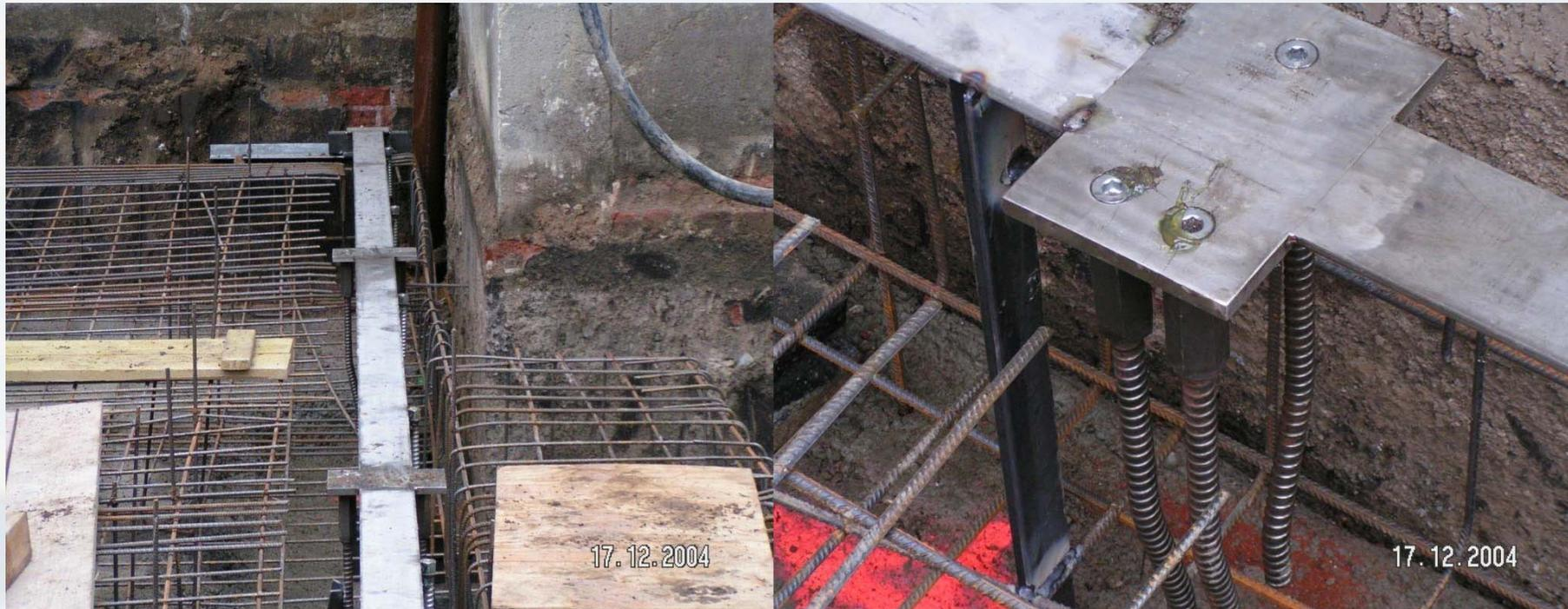
**Durante la instalación, los elementos prefabricados se montan, se alinean, y se hormigonan, - terminándolo.**
