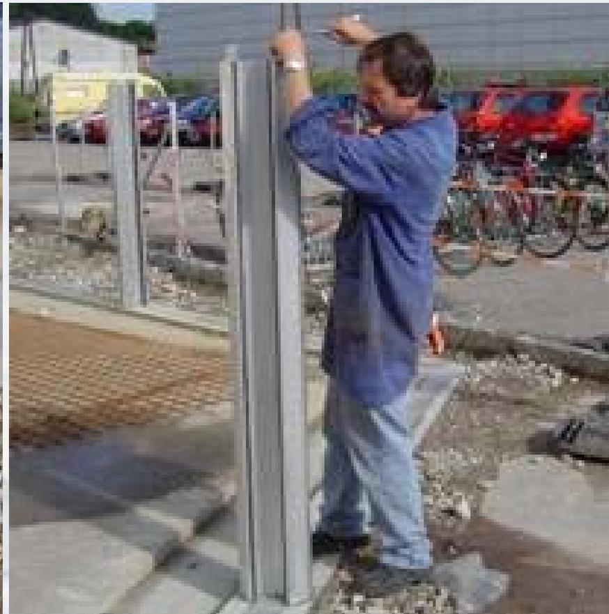
**Después del montaje de los bastidores, los paneles se pueden insertar fácil y rápidamente**
