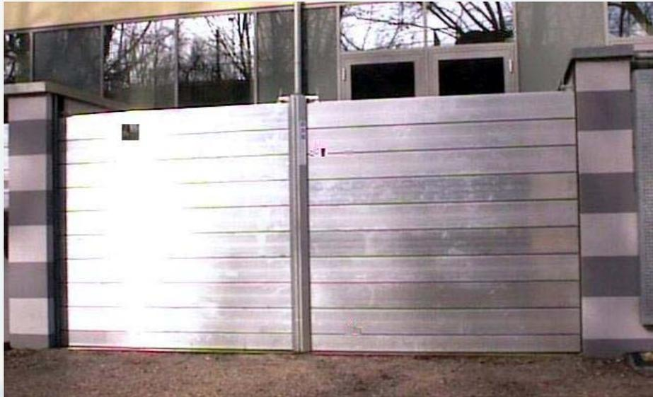
**Los bastidores de soporte de aluminio son generalmente libres de pie hasta una altura de 1,60 m. Depende de la anchura de la sección de alturas de protección de mayor tamaño, que se utilicen diferentes soportes traseros.**
