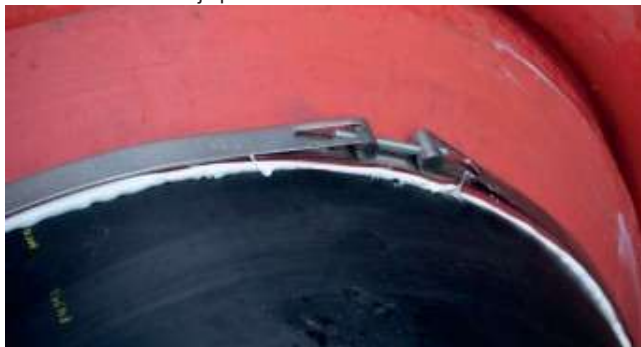
4 abrazaderas de acero inoxidable para tubos de diámetro exterior a partir de 315 mm. Par de apriete: 10 Nm
