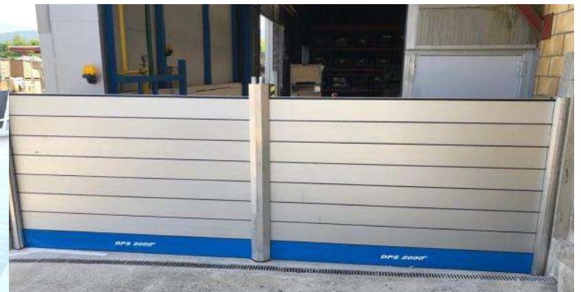
Entrada rampa 4,5m x 1,6m de alto
