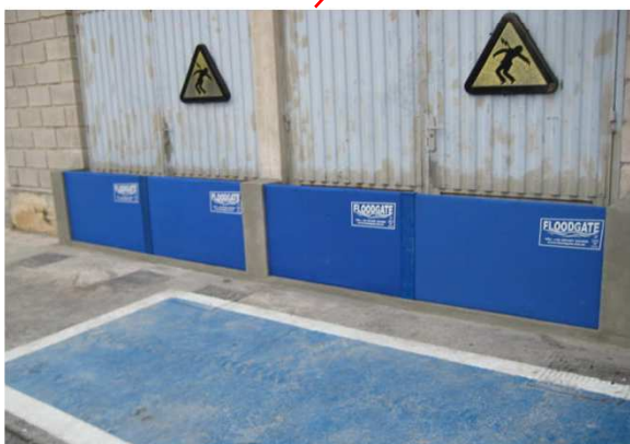
CENTRO DE TRANSFORMACION
