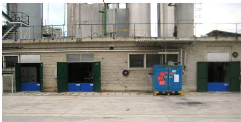
EDIFICIO 33 FACHADA ESTE
