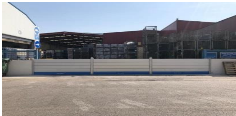
Entrada camiones 10m x 1,2m de alto
